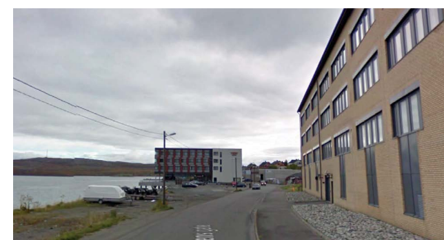
Figur 129: Bildet viser det overdimensjonerte politihuset i forgrunnen, Thon Hotel i sentrum og litt av vannkanten til venstre i bildet
