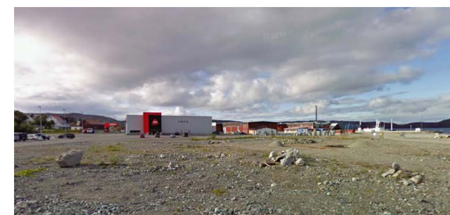
Figur 133: Bildet viser Byggmakker sett fra helt til høyre av tomta.
